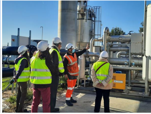
Unité de transformation de gaz issus de la fermentation des déchets
